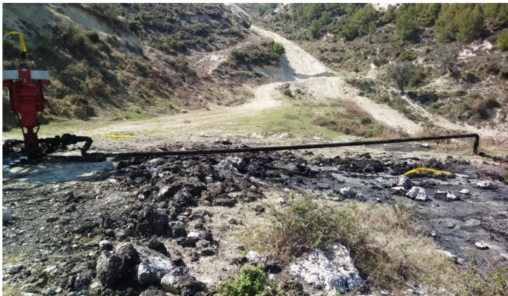
Foto 17. Toka të ndotura në instalimet sipërfaqësore të një pusi në vendburimin e Ballshit
